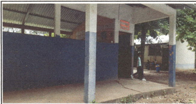
Columna y piso en mal estado necesita sustituir,
